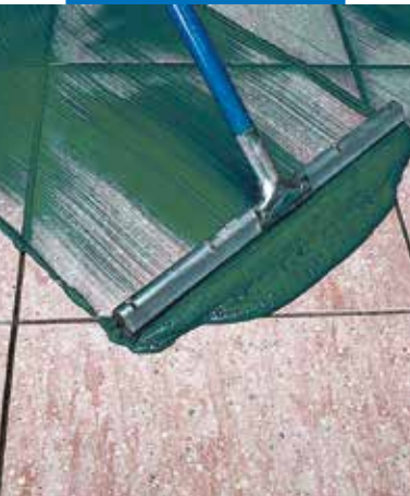
Rozprowadzanie zaprawy Ultracolor Plus przy użyciu gumowej rakli
