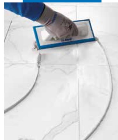
Spoinowanie płytek imitujących kamień naturalny
