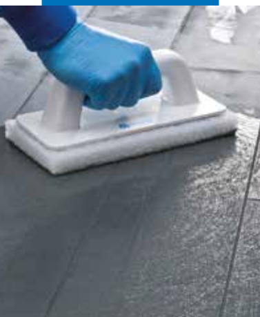
Czyszczenie i profilowanie fug pacą typu Scotch-Brite®
