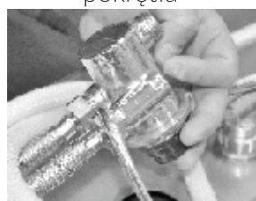
6. odkręcenie przyłącza wody
