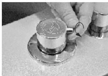
2. odkręcić wystający element pokrętła
