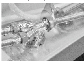
6. odkręcenie przyłączy wody
