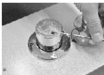
3. odkręcenie pokrętła
